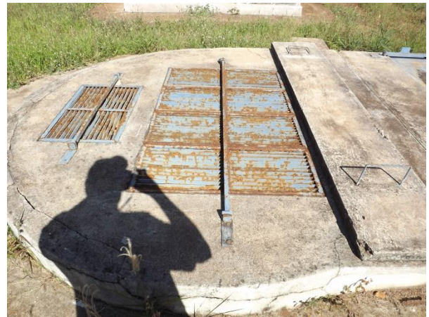
Foto 3.86 - Chegada da Tubulação e Tapa do Poço de Sucção
