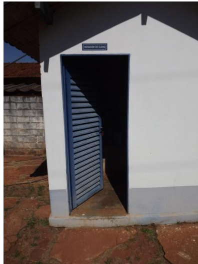
Foto 3.36 – Casa de Química - Dosagem de Cloro na Área do Poço Distrito Industrial.
