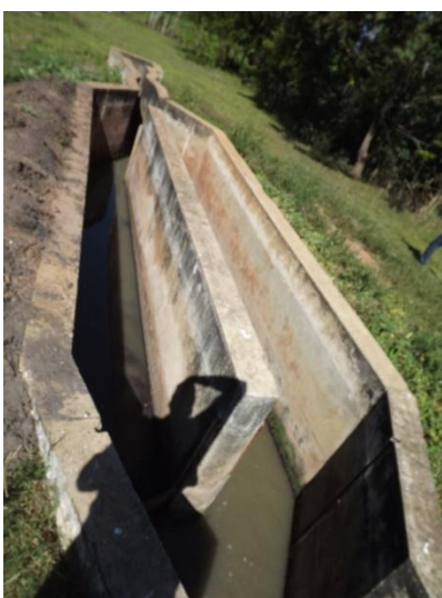
Foto 3.94 – Detalhe Caixa de Areia.
