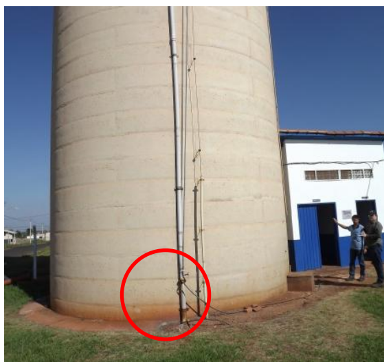
Foto 3.24 – Aplicação do Cloro na chegada do P07 (REL Jardim Moleiro).
