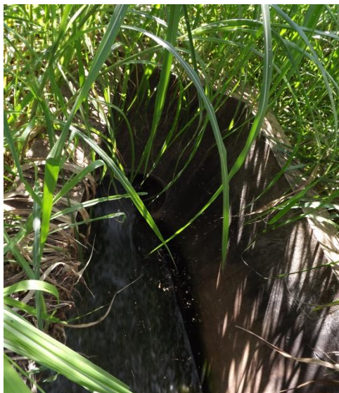
Foto 3.98 – Saída o Emissário na Escada Hidráulica.
