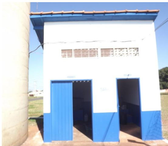
Foto 3.22 – Casa de Química - Dosagem de Cloro e Flúor na área do REL Moleiro
