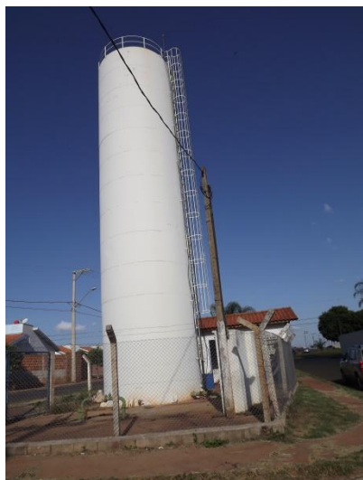
Foto 3.56 – RAP Nosso Teto.
