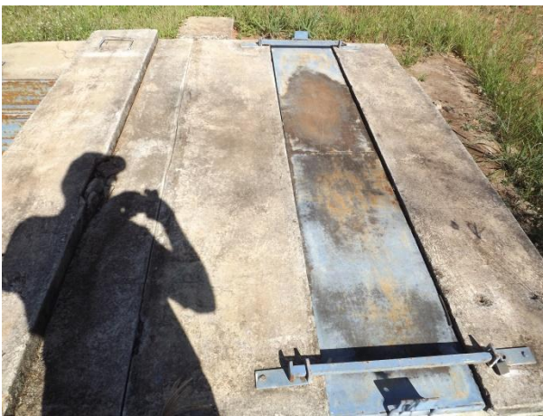
Foto 3.85 - Caixa de Válvulas.
