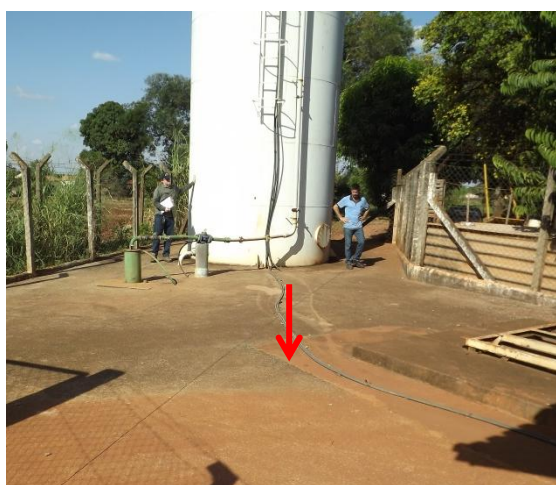
Foto 3.30 – Adutora do P11 Patrimônio – Ponto de Aplicação.
