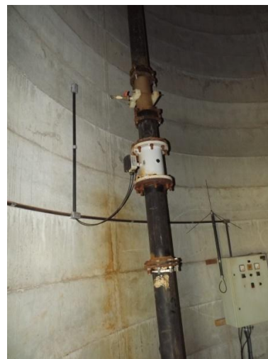
Foto 3.23 – Aplicação de Flúor na AAT Tiradentes (REL Moleiro).
