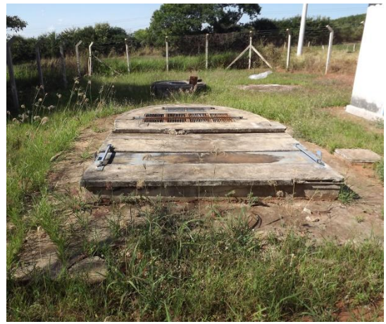
Foto 3.84 - Vista Geral EEE Santa Lúcia
