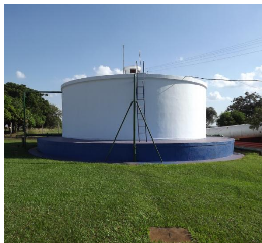
Foto 3.69 – CR Recinto-RAP Recinto.
