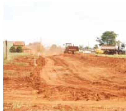
Construção de galerias ao longo do canteiro central da Avenida Luiz Lemos de Toledo
